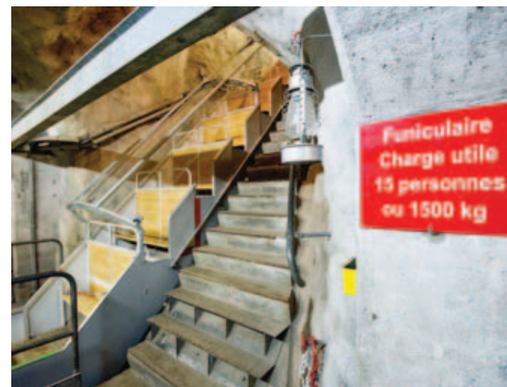
Sous le funiculaire, des tuyaux sont utilisés pour ventiler et alimenter Savatan en eau. Le courant créé en aval fait le chemin inverse. HOFMANN
