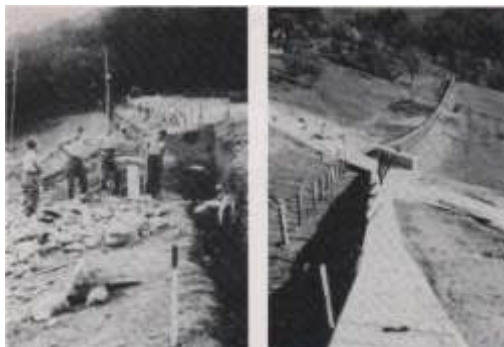
Automne 1940, T7001, barrage et mur en construction
