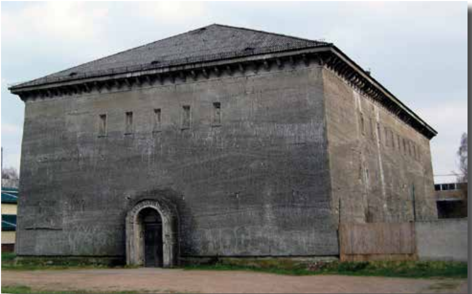
Luftschutzbunker Wittenauer Straße 76/80, Berlin
