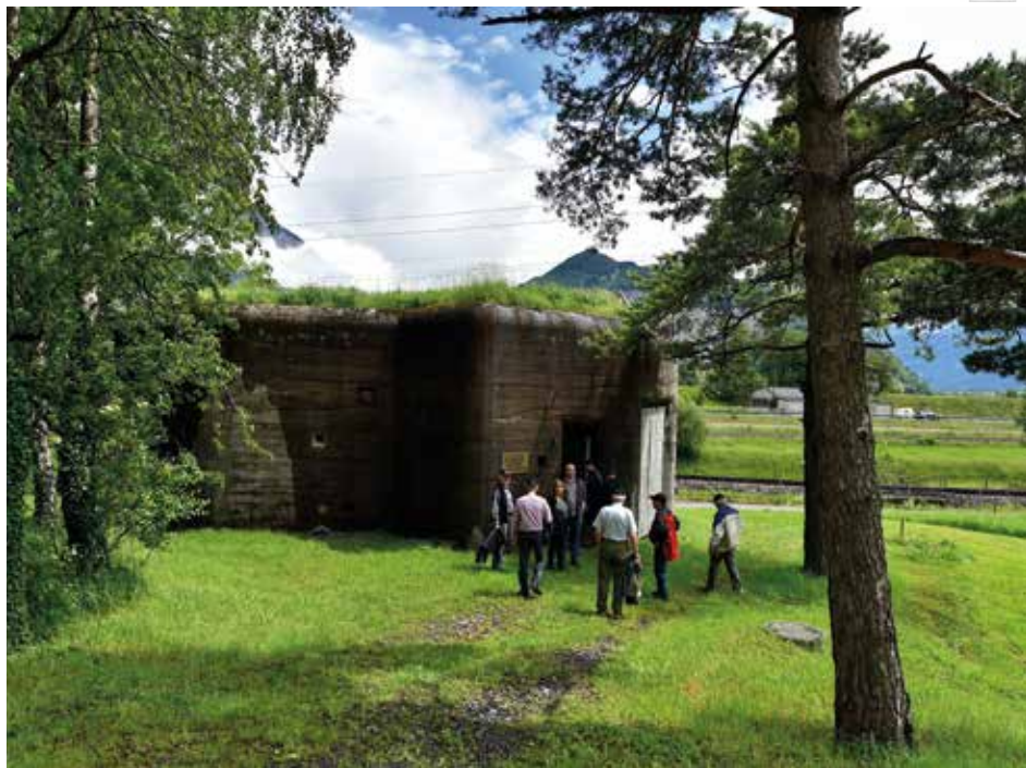
Ouvrage antichars au bord du Rhin
