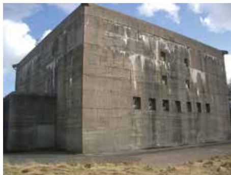
Truppenmannschaftsbunker T-750, Wilhelmshaven
