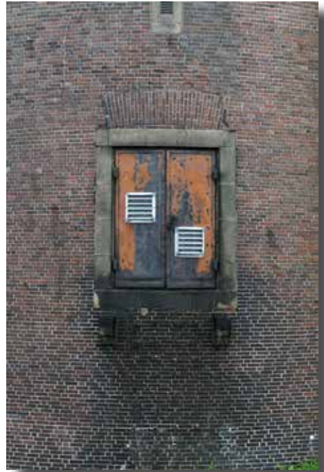
Entrée supérieure d'une LS-Turm Zombeck, Hambourg, Vorsetzen (2016)
