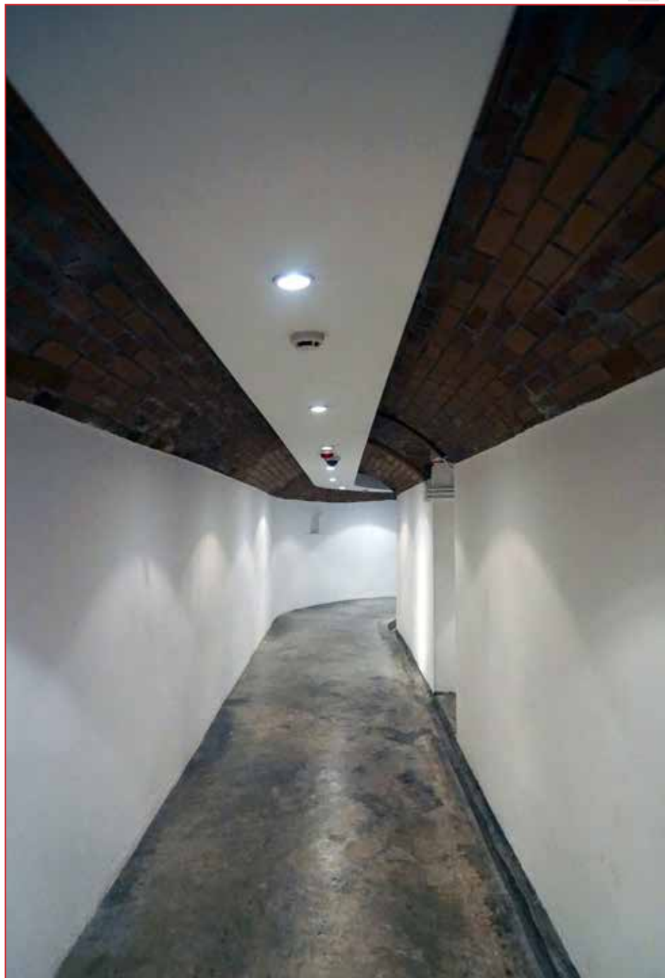
Fort Lei Yue Mun – Couloir de liaison entre la redoute et une caponnière (2016)
